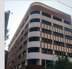
پروژه تجاری شهریار، تهران
