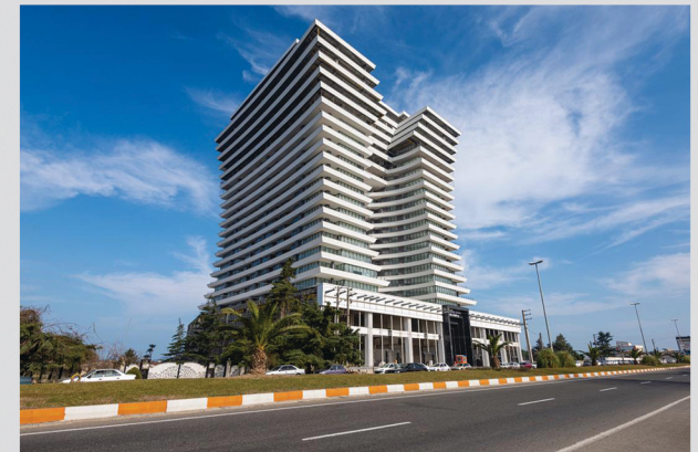
پروژه تجاری برج آفرینش رامسر، نما فایبر سمند ۱۸ مبل دی پی، دیوار پیش ساخته داخلی وال اسپید
